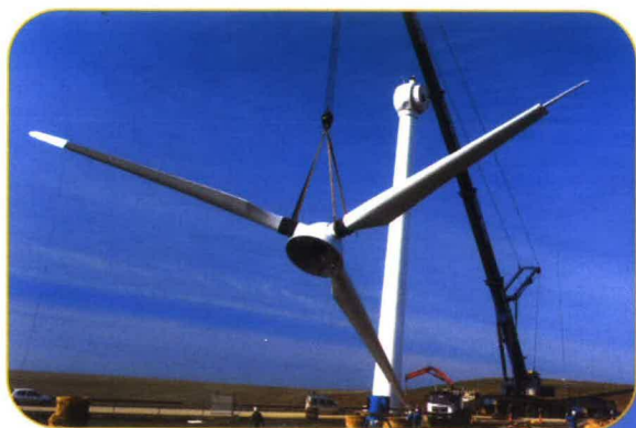
Assemblage du rotor avec la nacelle
