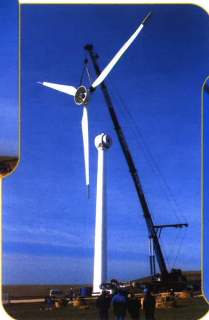
Assemblage du rotor avec la nacelle
