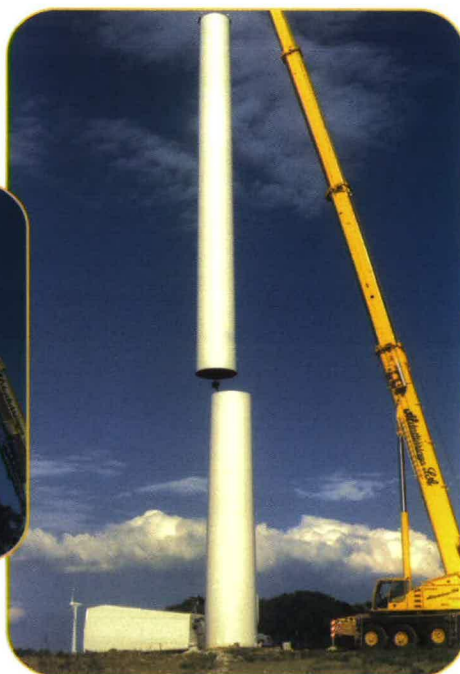
Montage (assemblage) de la tour
